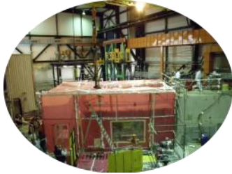
Travaux de démantèlement du silo HAO (Haute Activité Oxyde) - AREVA
